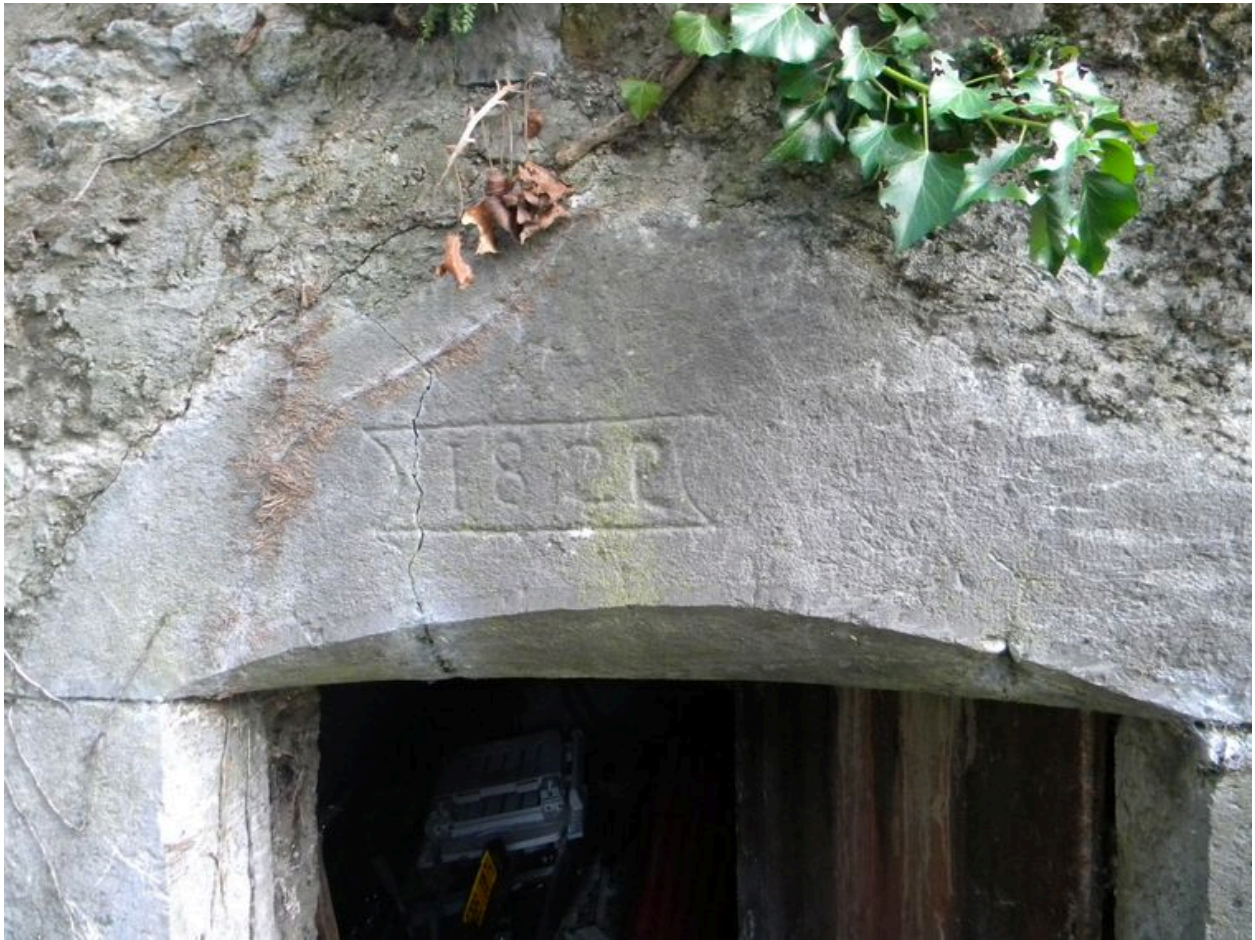
Détail d'un linteau de porte délardé avec cartouche portant la date de 1822.
