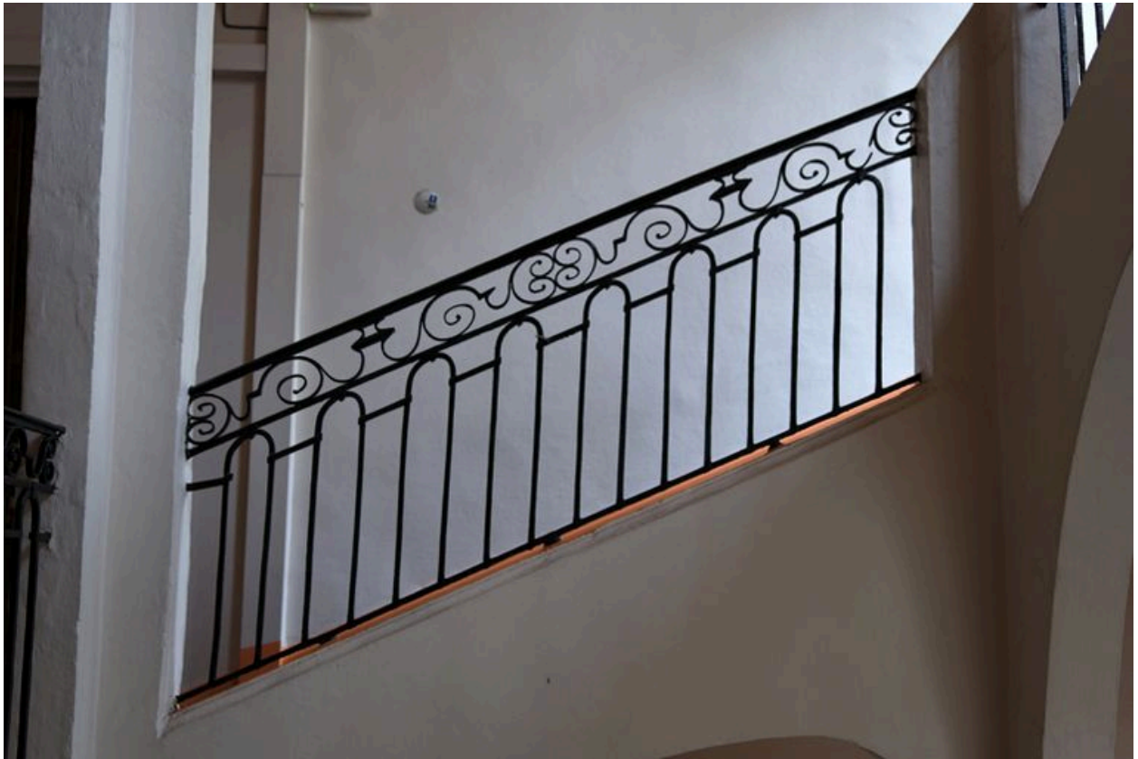
Escalier, détail de la rampe
