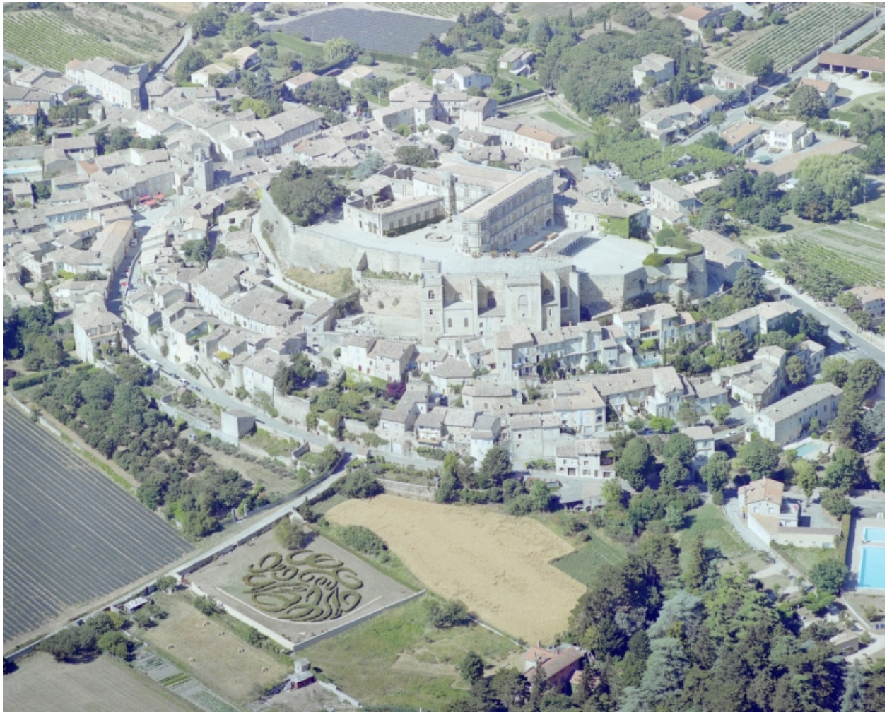
Vue aérienne prise du sud.
