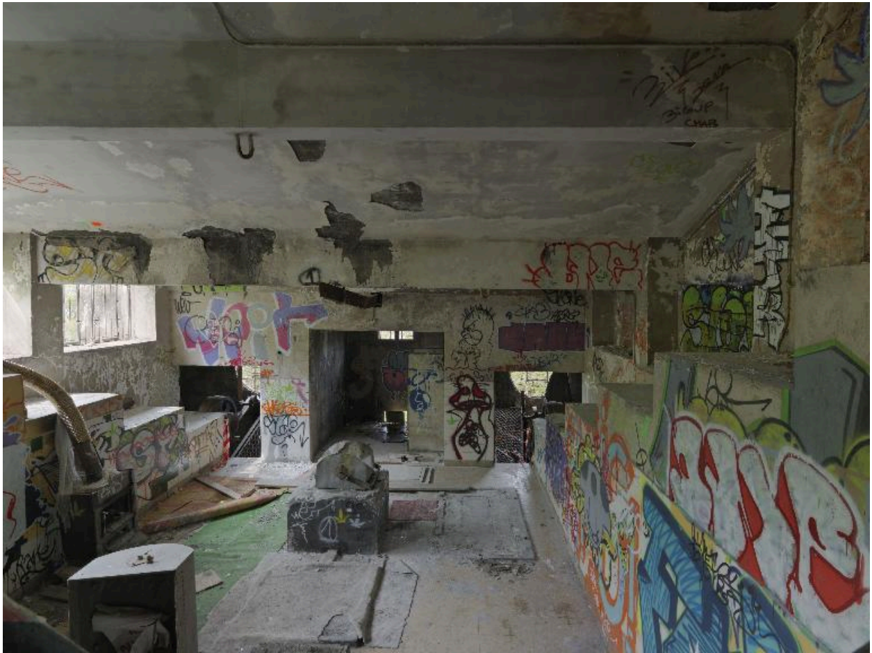
Salle des machines
