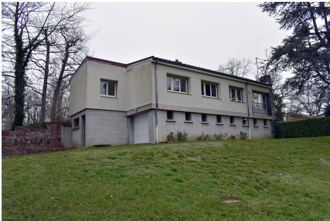
Maison : logement de fonction D, depuis l'ouest
