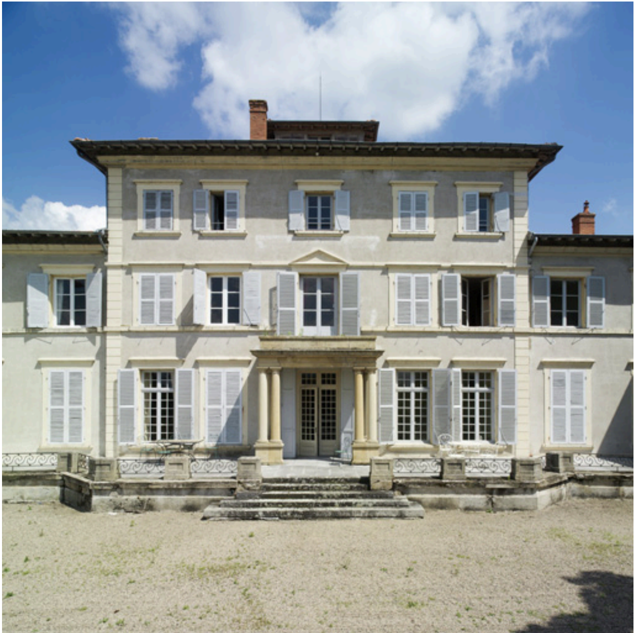
Partie centrale de la façade sur jardin, depuis l'ouest.
