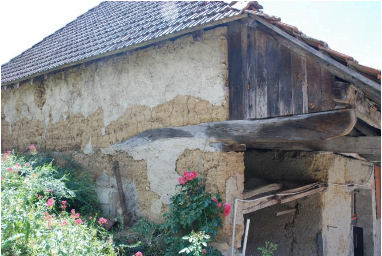
Grange-étable sud, détail du pignon en pisé.
