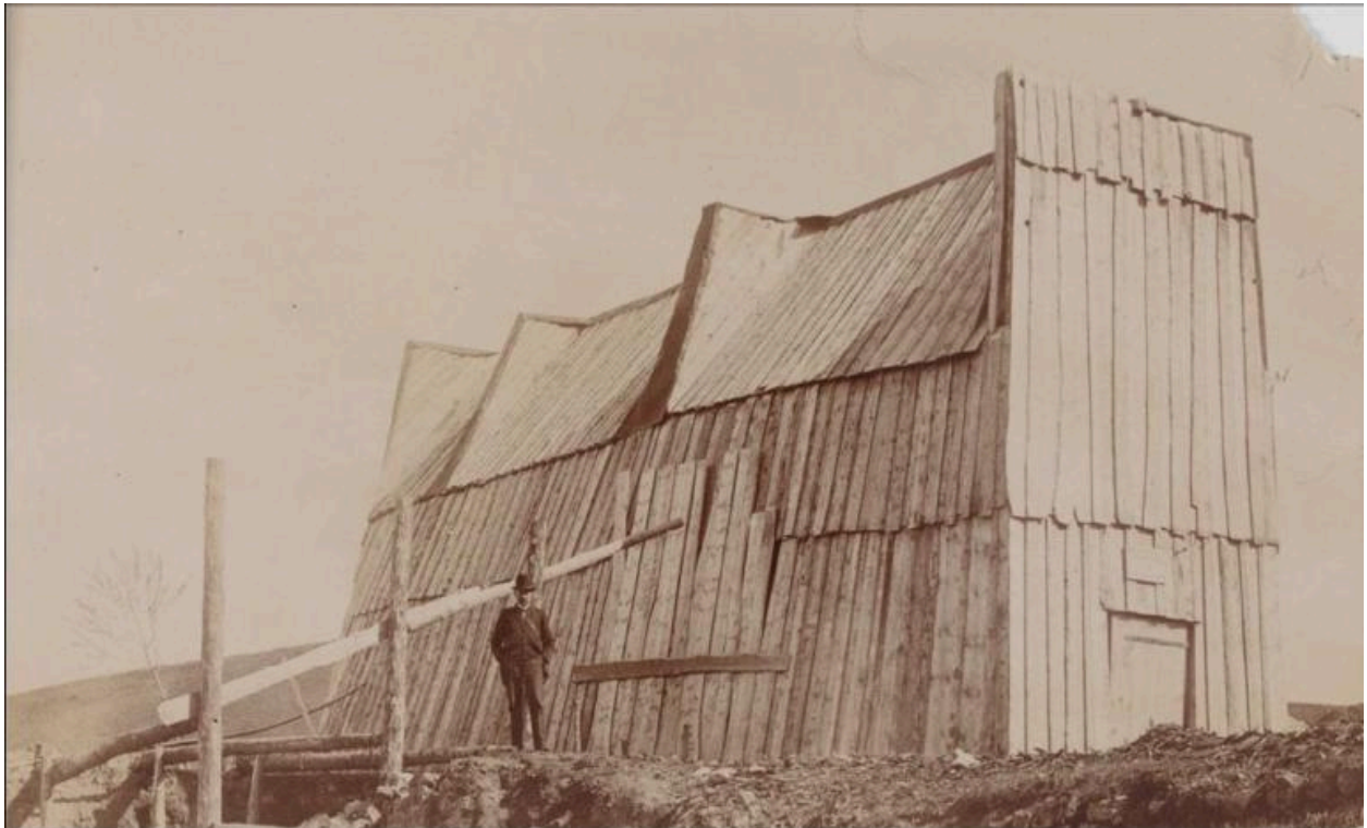
Vue du bâtiment du puits de la mine à la fin du XIXe siècle
