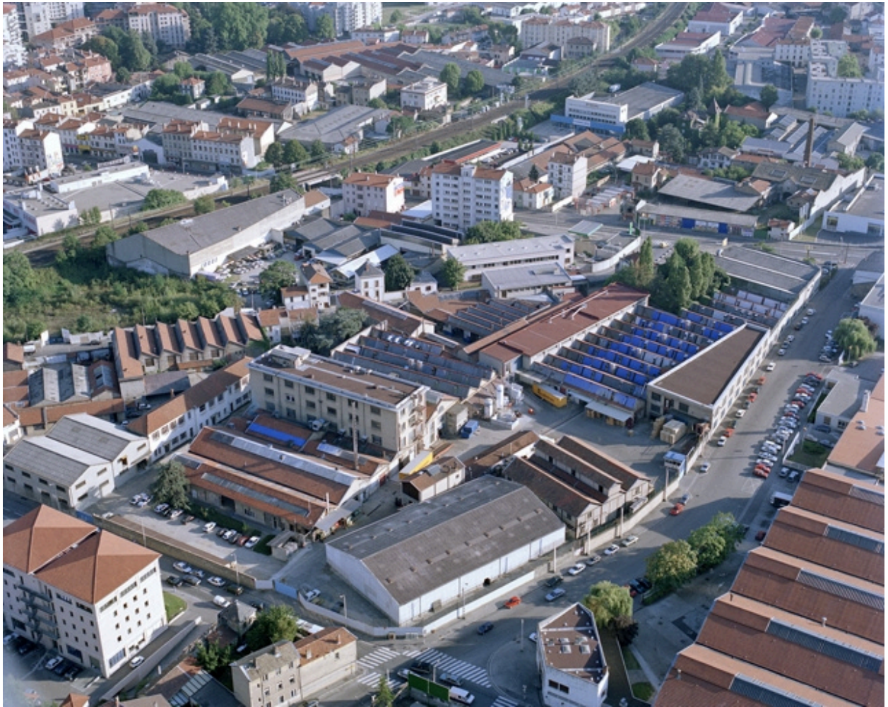
Vue d'ensemble nord, rue Diebold
