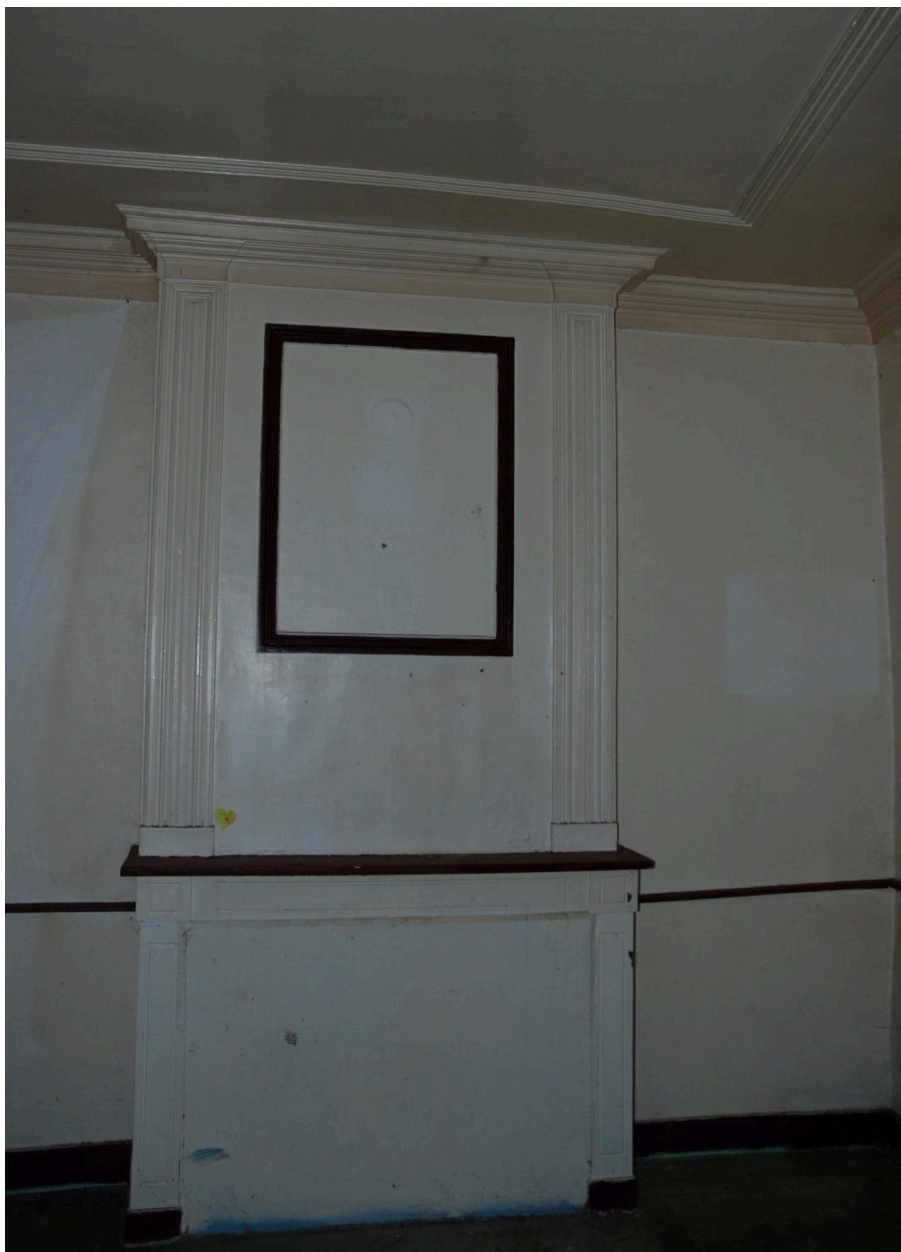
Vue intérieure de la pension de famille, rez-de-chaussée surélevé : pièce de l'angle sud-est, cheminée.
