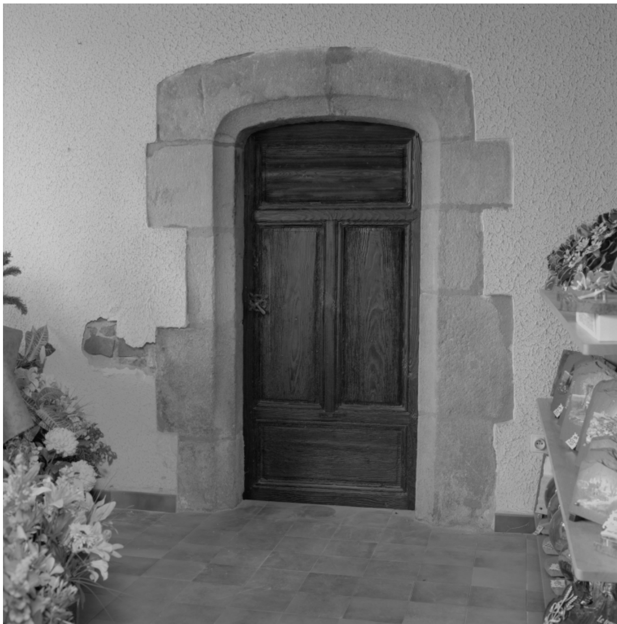
Vue générale intérieure d'une porte du rez-de-chaussée.
