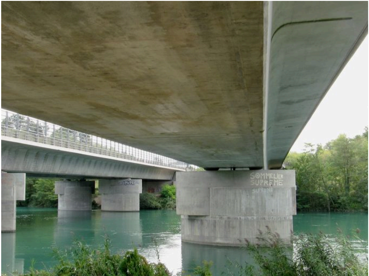
Vue sous du tablier, partie du pont sur le canal de Jonage (depuis la rive droite)
