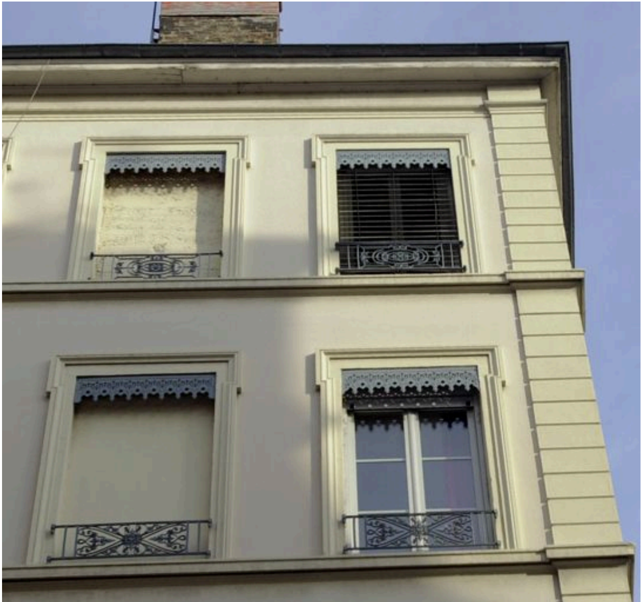
Vue des baies des deux derniers étages
