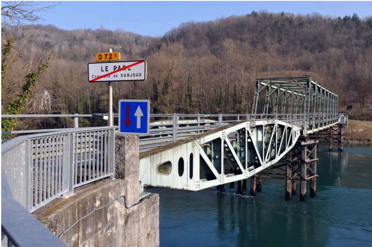
Vue générale, de côté, face aval (depuis la rive droite)
