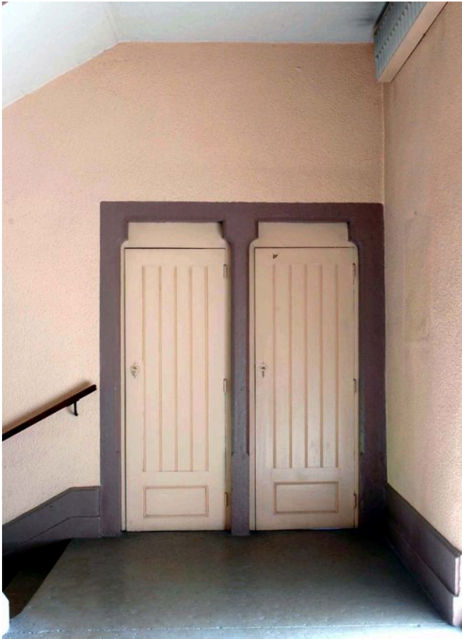
Escalier principal, portes au niveau du premier repos
