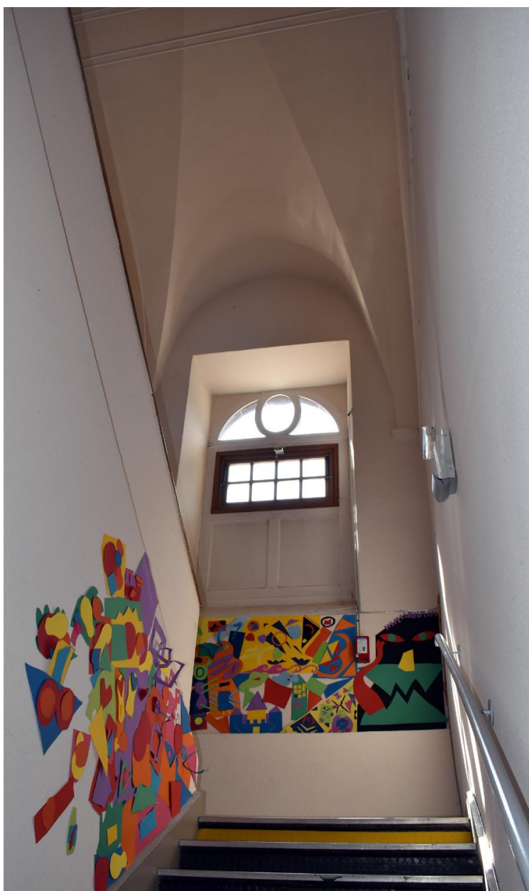
Bâtiment D : escalier E, trémie ouverte dans une travée de l'ancienne chapelle de la congrégation des écoliers et ancienne porte d'entrée de cette chapelle
