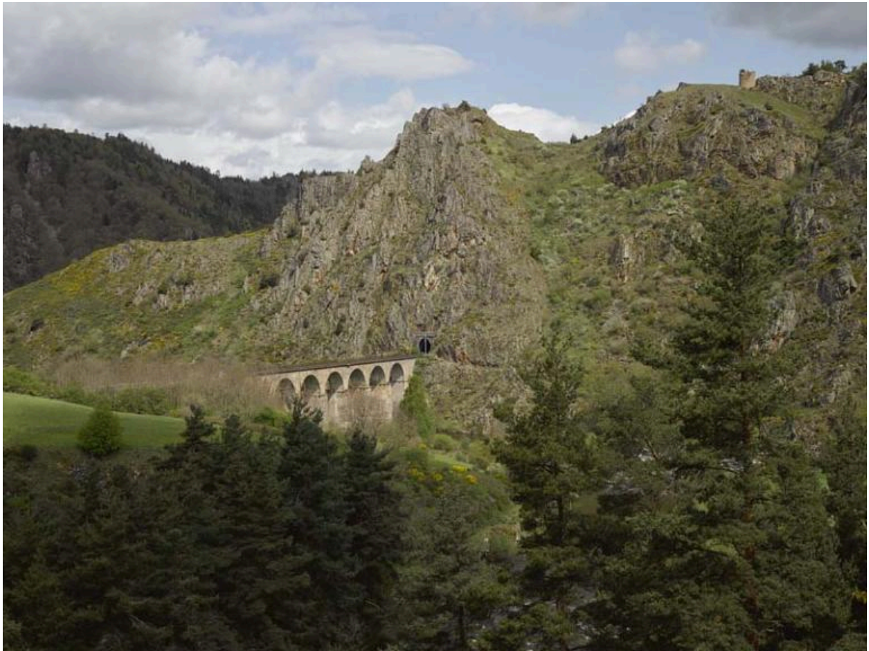
Tunnel du Thord et viaduc ferroviaire sur l'Allier aux confins de la Haute-Loire, au nord du Nouveau Monde et de Chapeauroux.
