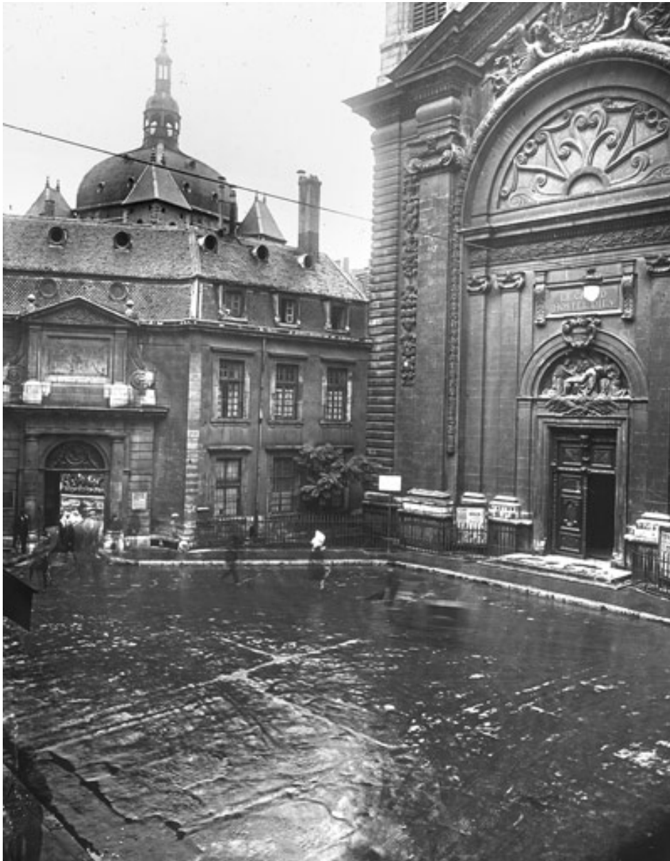
Façade de la chapelle et entrée de l'hôpital. Photogr., [mil. XXe s.] (A. Musée des HCL)
