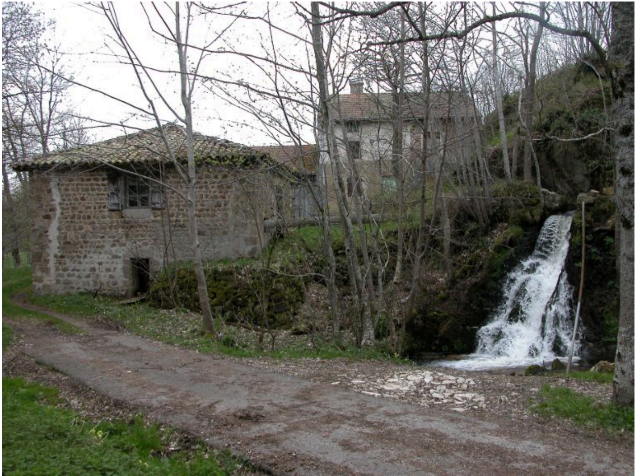
Vue d'ensemble du moulin de trois-quarts sud-ouest.
