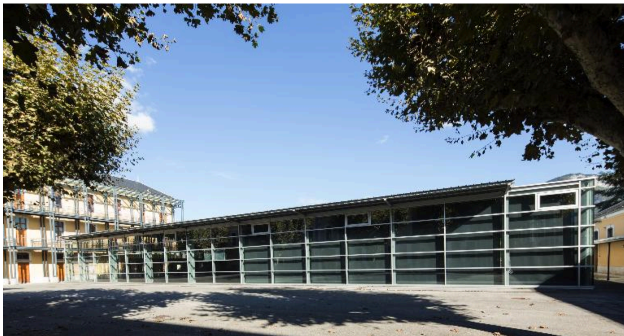
Façade sur cour 1.
