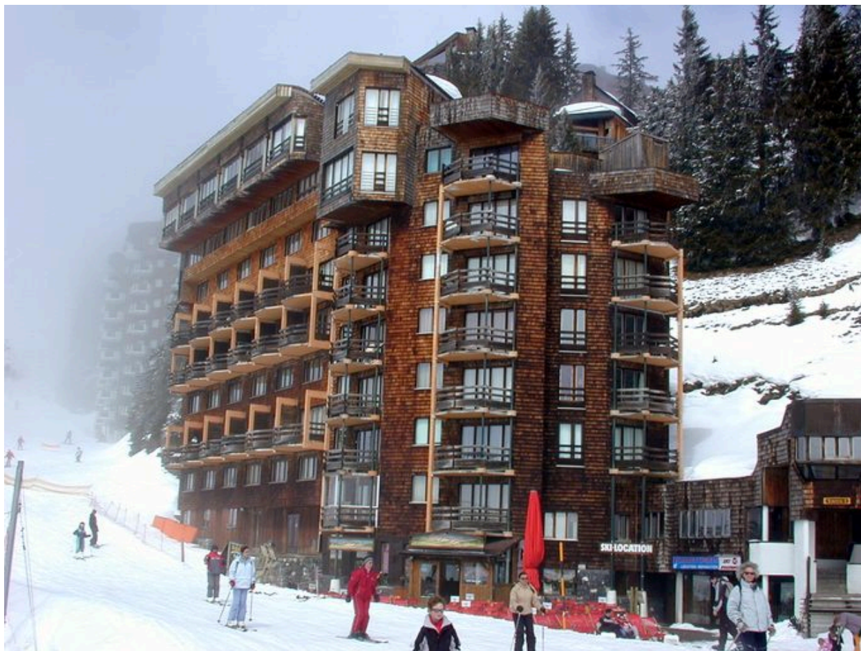
Vue depuis le sud
