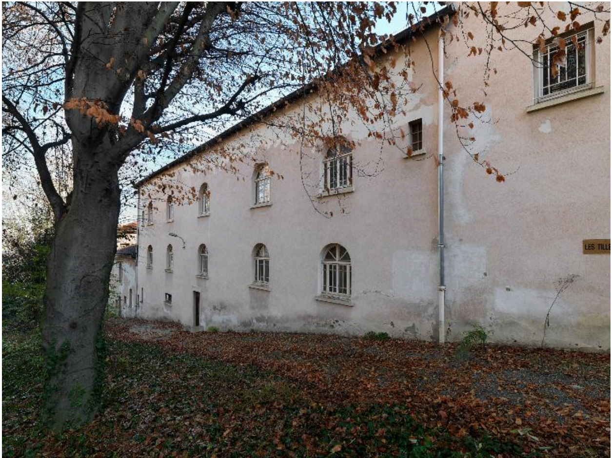
Bâtiment central, dit "les Mûriers", élévation occidentale
