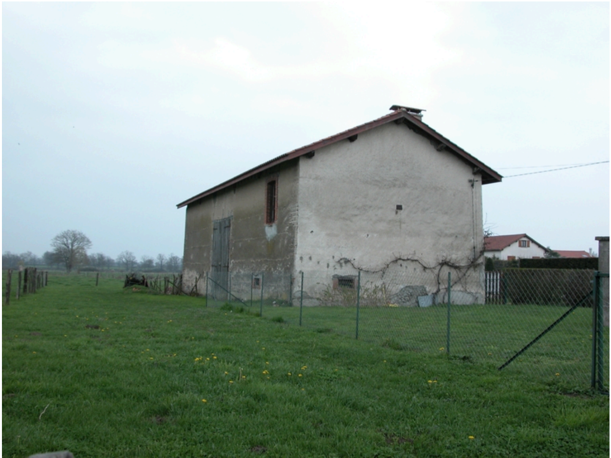
Vue générale de trois-quarts arrière.
