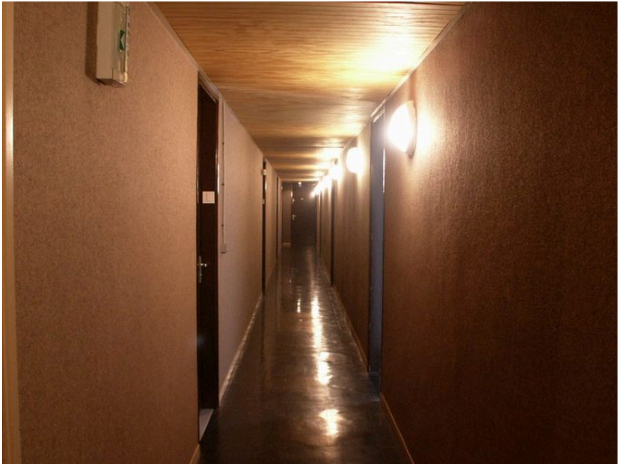
Couloir de distribution des appartements
