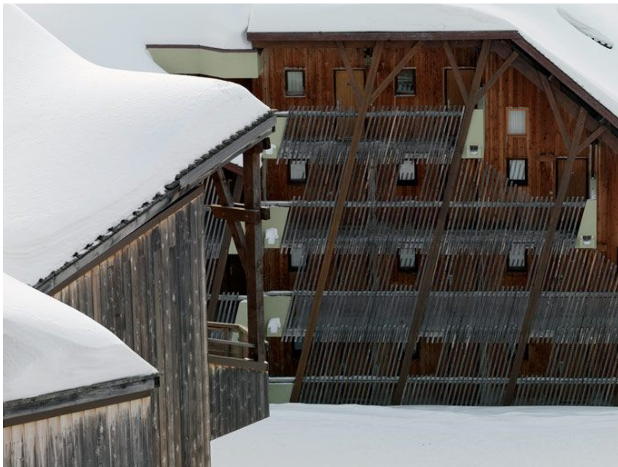
Elévation nord. Partie ouest
