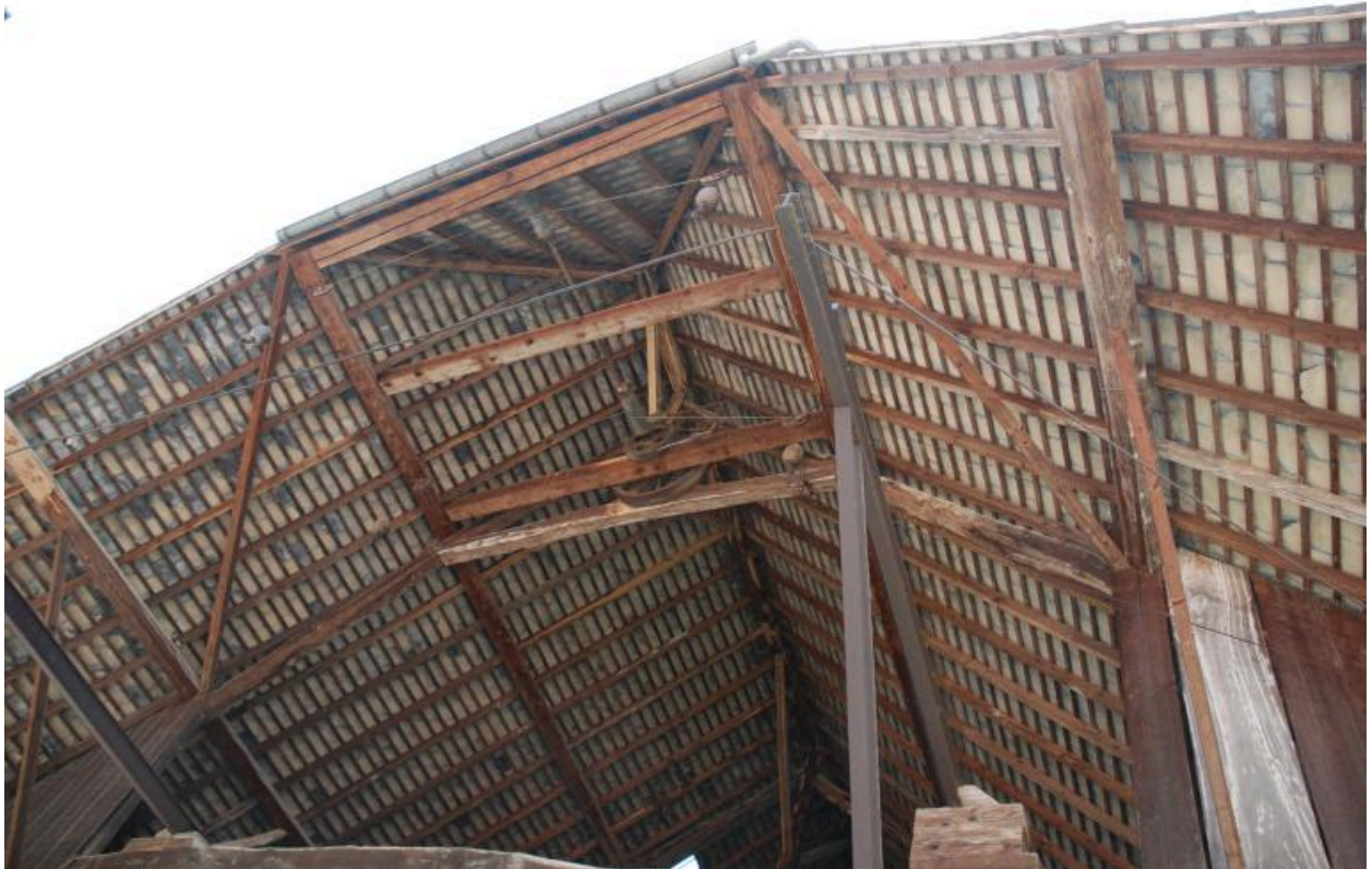
Détail du monte-foin à quatre câbles.
