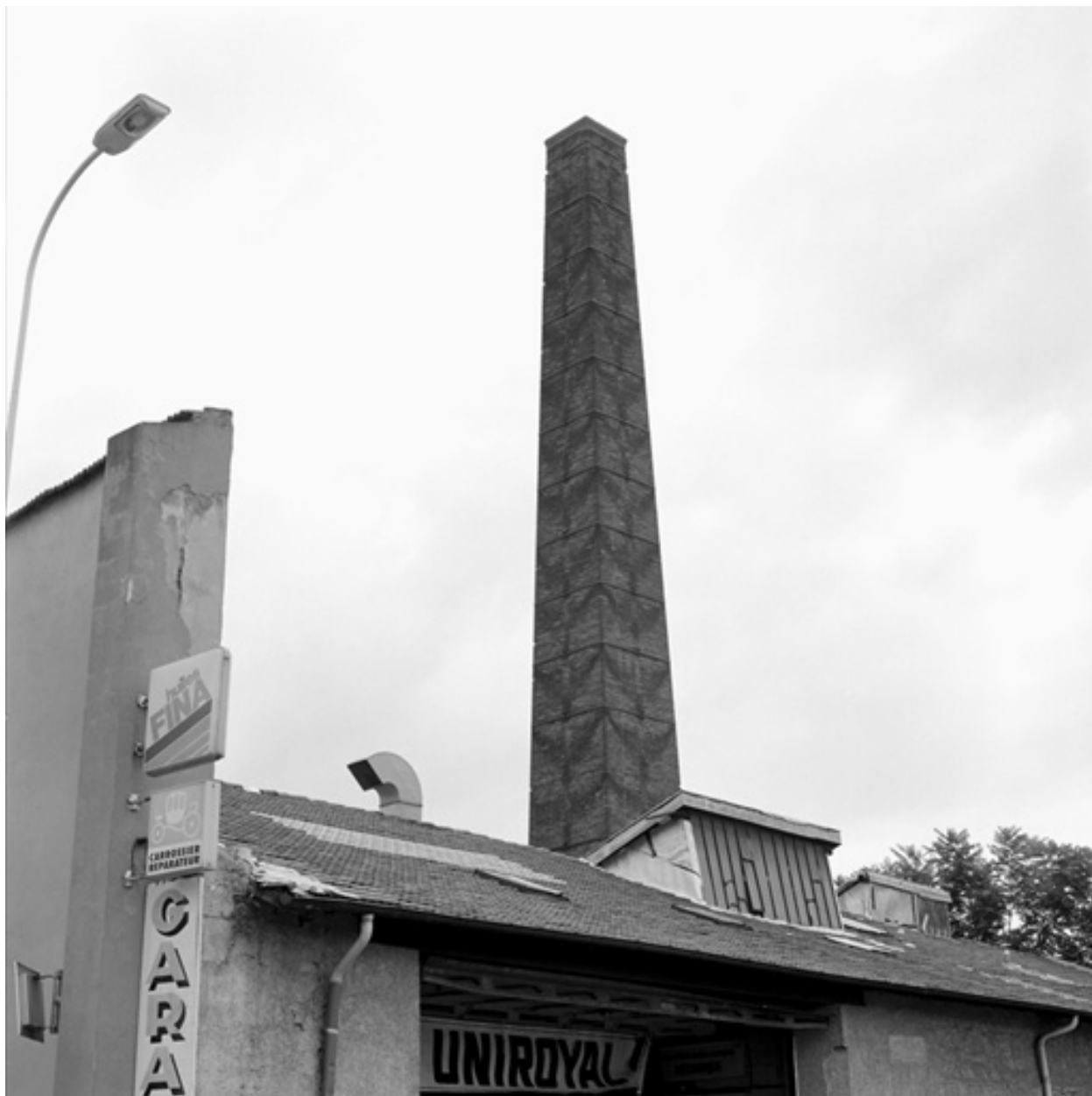
Détail cheminée quadrangulaire
