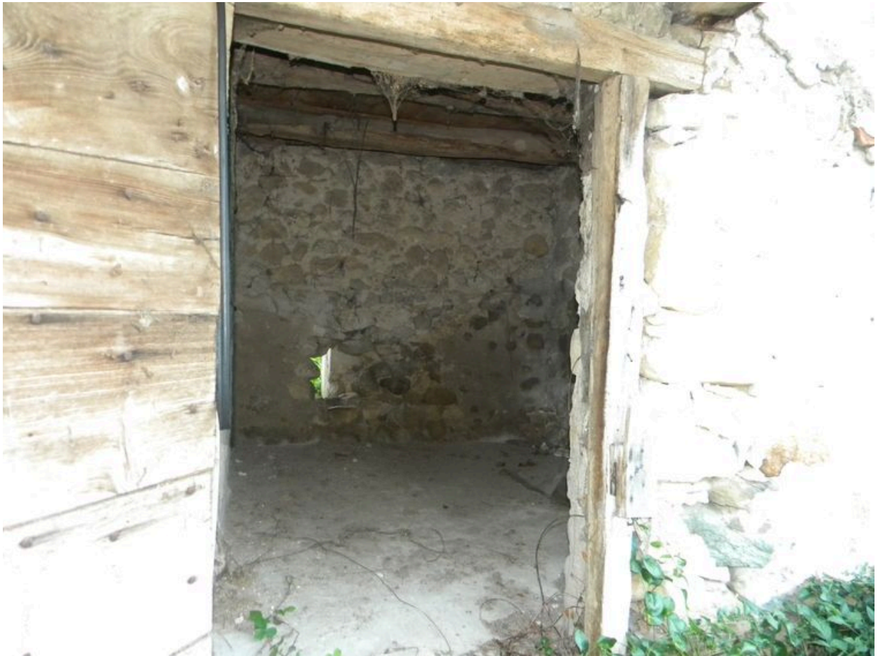
Vue du rez-de-chaussée côté sud-ouest : porte d'entrée d'une probable cave.
