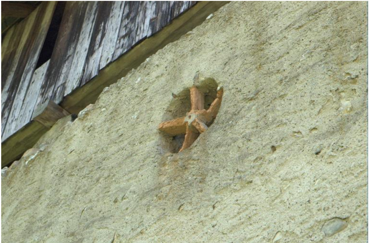
Détail d'une ventilation du fenil, mur pignon est.
