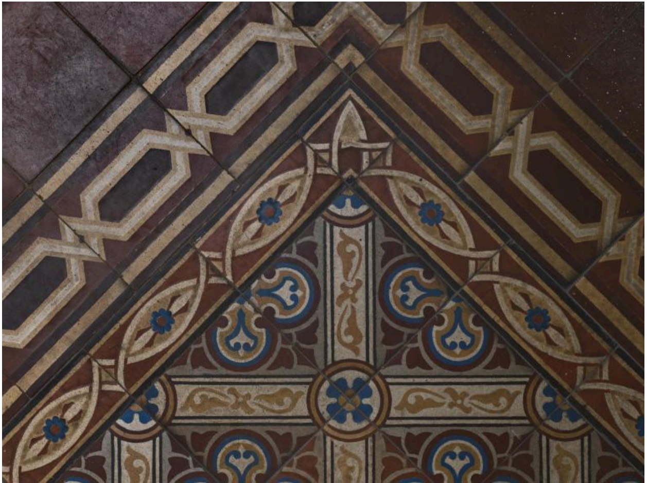
Salle Rameau : escalier C, revêtement de sol en carreaux de ciment au rez-de-chaussée
