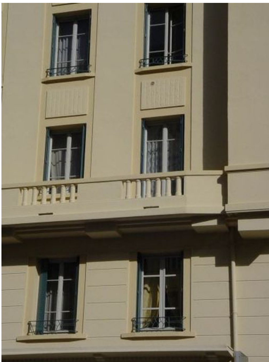
Détail de l'élévation
