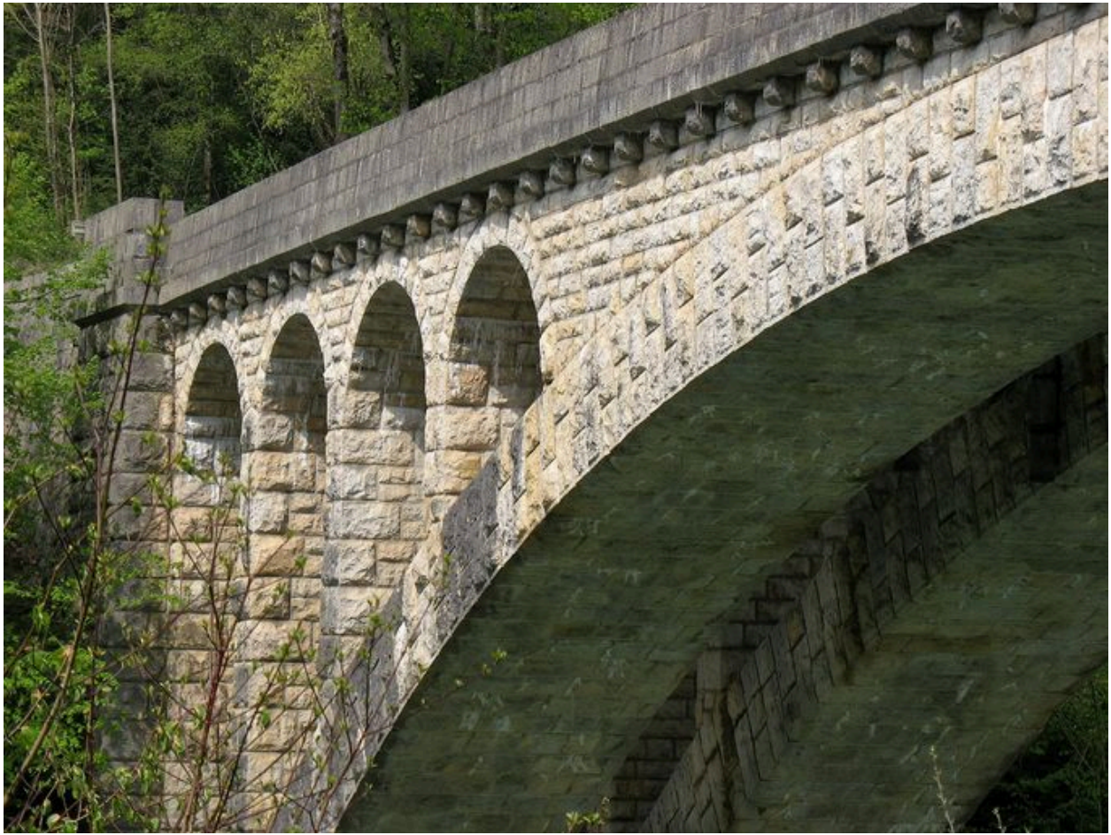
Vue partielle, face aval
