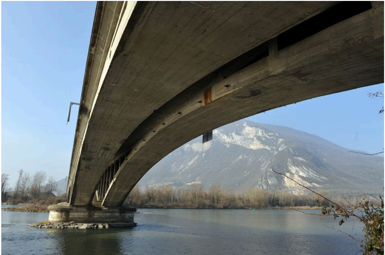
Vue générale, de dessous, face aval (depuis la rive gauche)
