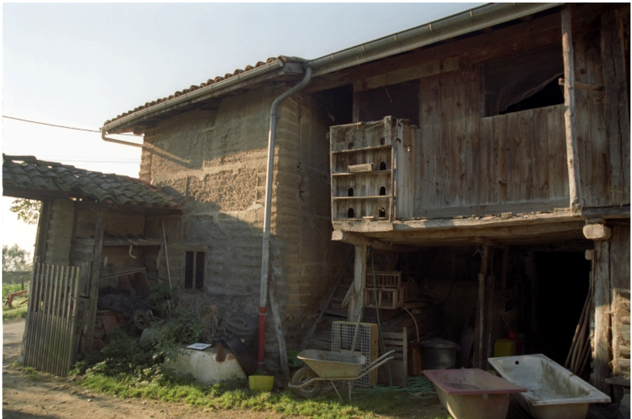
Vue du grenier et de la partie sud du hangar devant la grange-étable.
