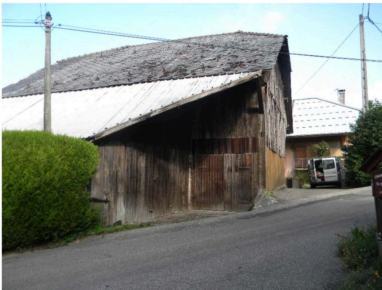
Vue d'ensemble d'une grange (2008 E8 1067, 1068, 1069).
