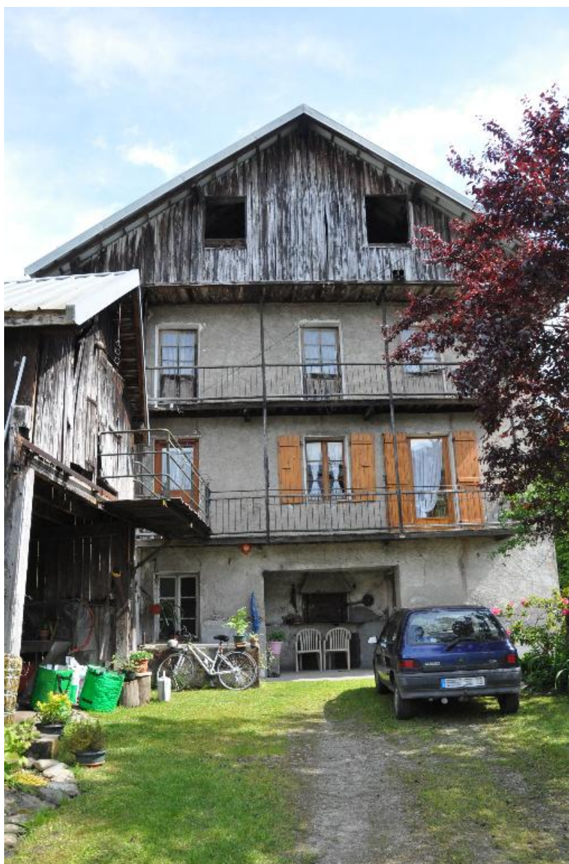
Vue de la minoterie Simillon située en aval.
