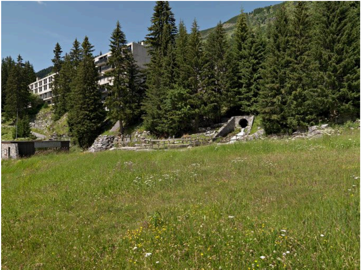
Flaine Front de Neige. Sortie du ruisseau canalisé sous la butte de Flaine Forum
