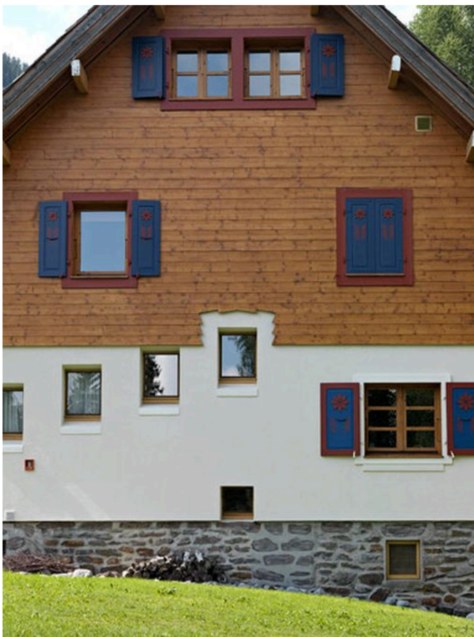
Elévation postérieure, partie centrale
