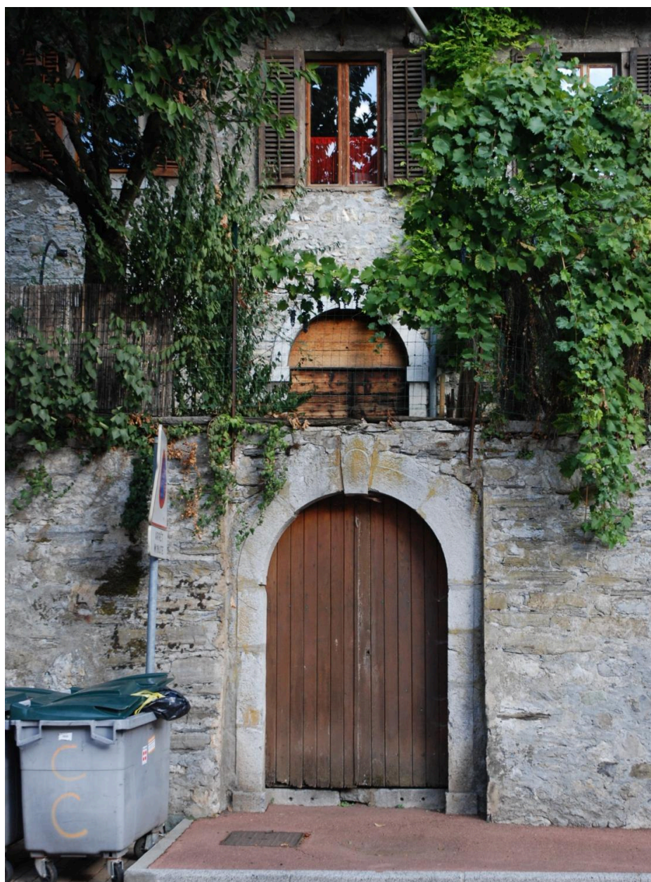
Vue de la porte du jardin et de la porte de l'étage de soubassement, depuis l'ouest.
