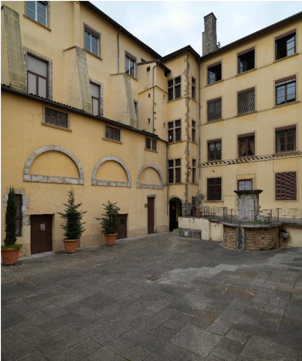
La cour : angle sud-ouest
