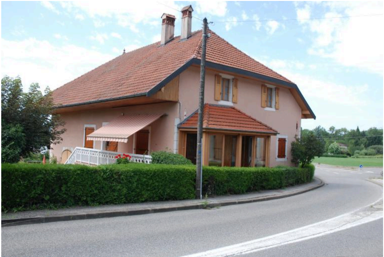
2015 C5 307, la Ravoire, ferme. Vue d'ensemble de trois-quarts avant droit.
