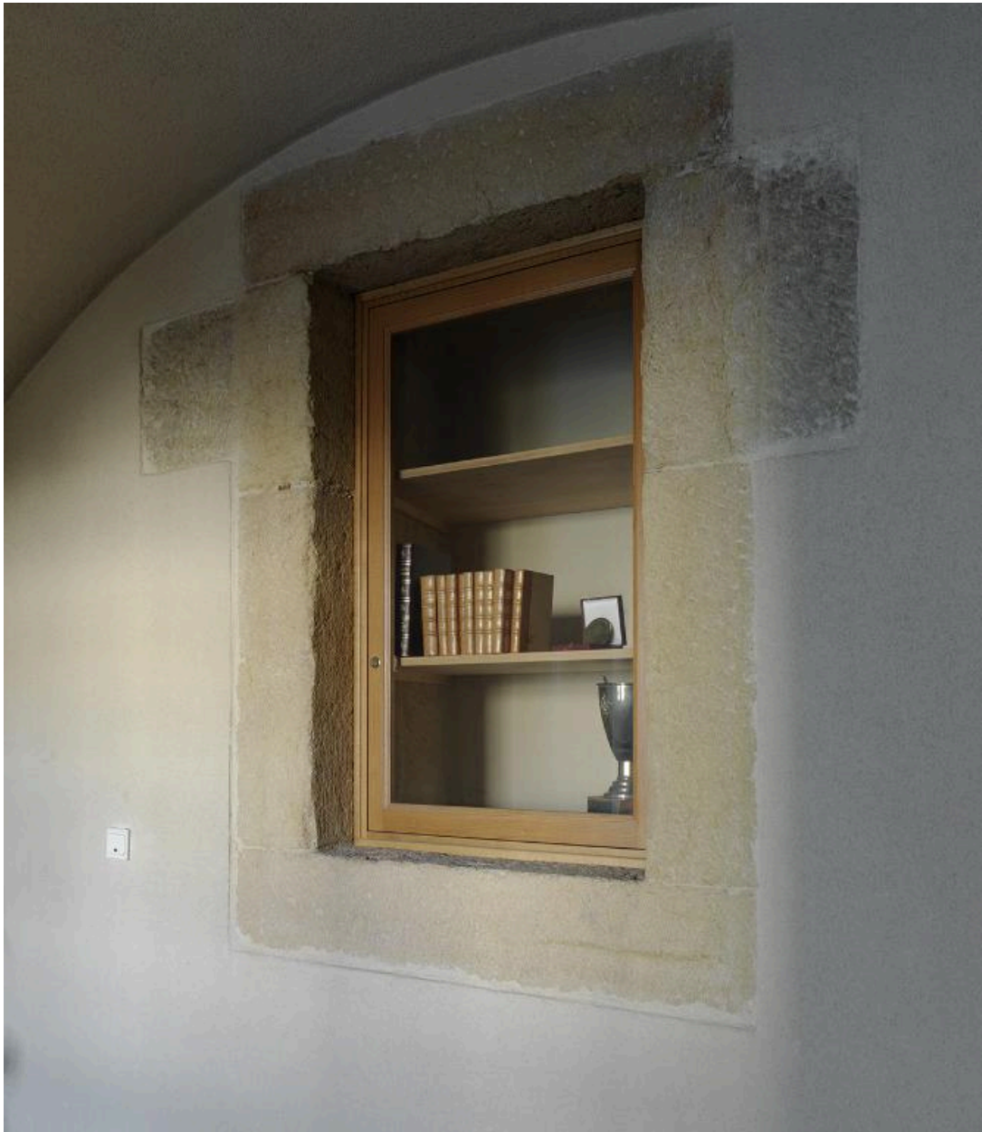
Cour d'honneur, corps de bâtiment sud, 2e étage, niche pratiquée dans le mur
