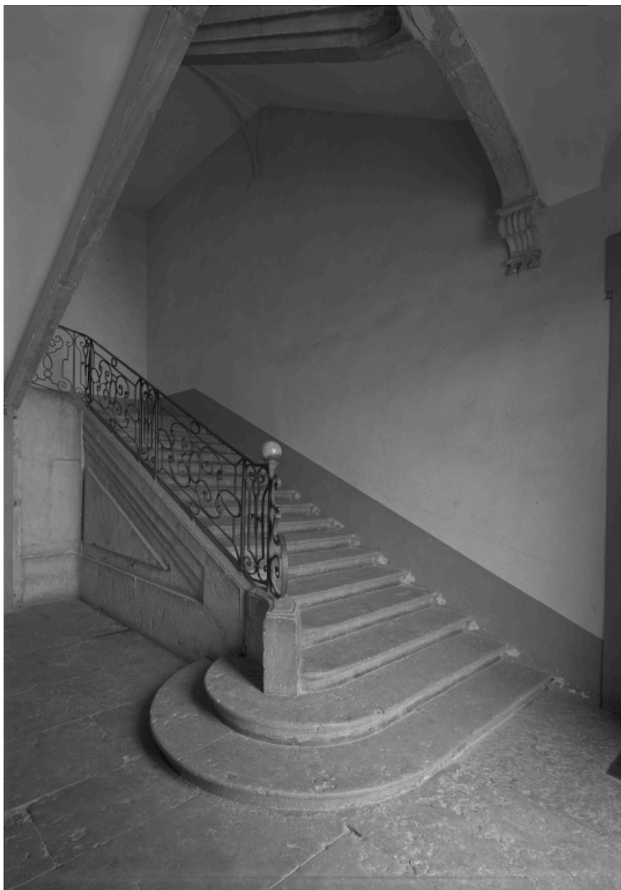
Escalier d'honneur, première volée.
