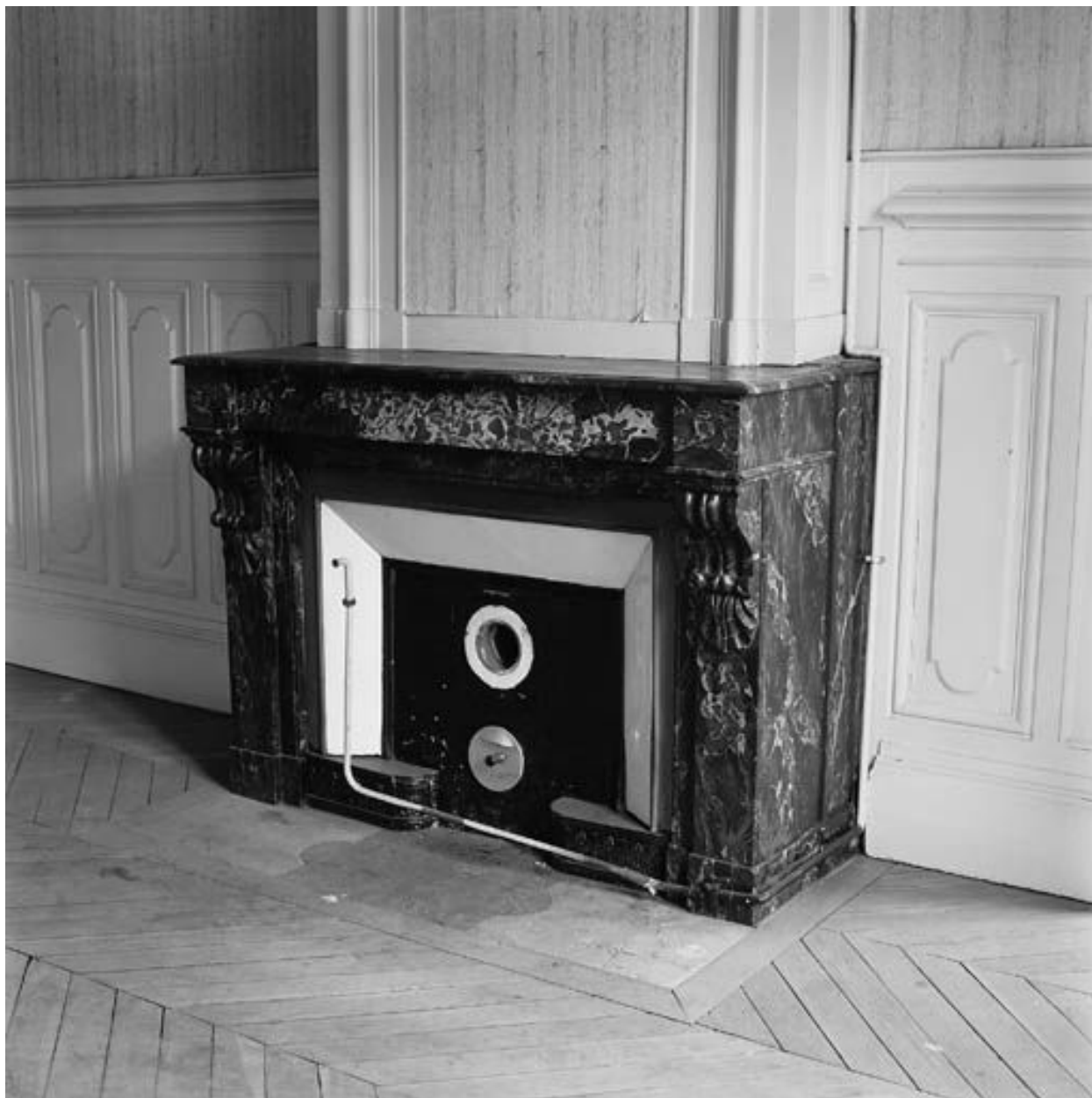
Deuxième étage : cheminée en marbre Portor
