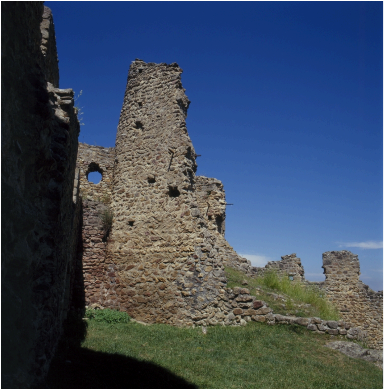
Château-fort primitif, partie nord : détail de la tour carrée dite tour des Dames ou Damas, du sud-ouest.
