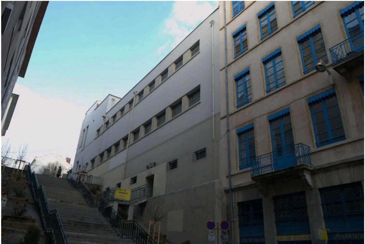
Façade ouest rue Prunelle/Ornano
