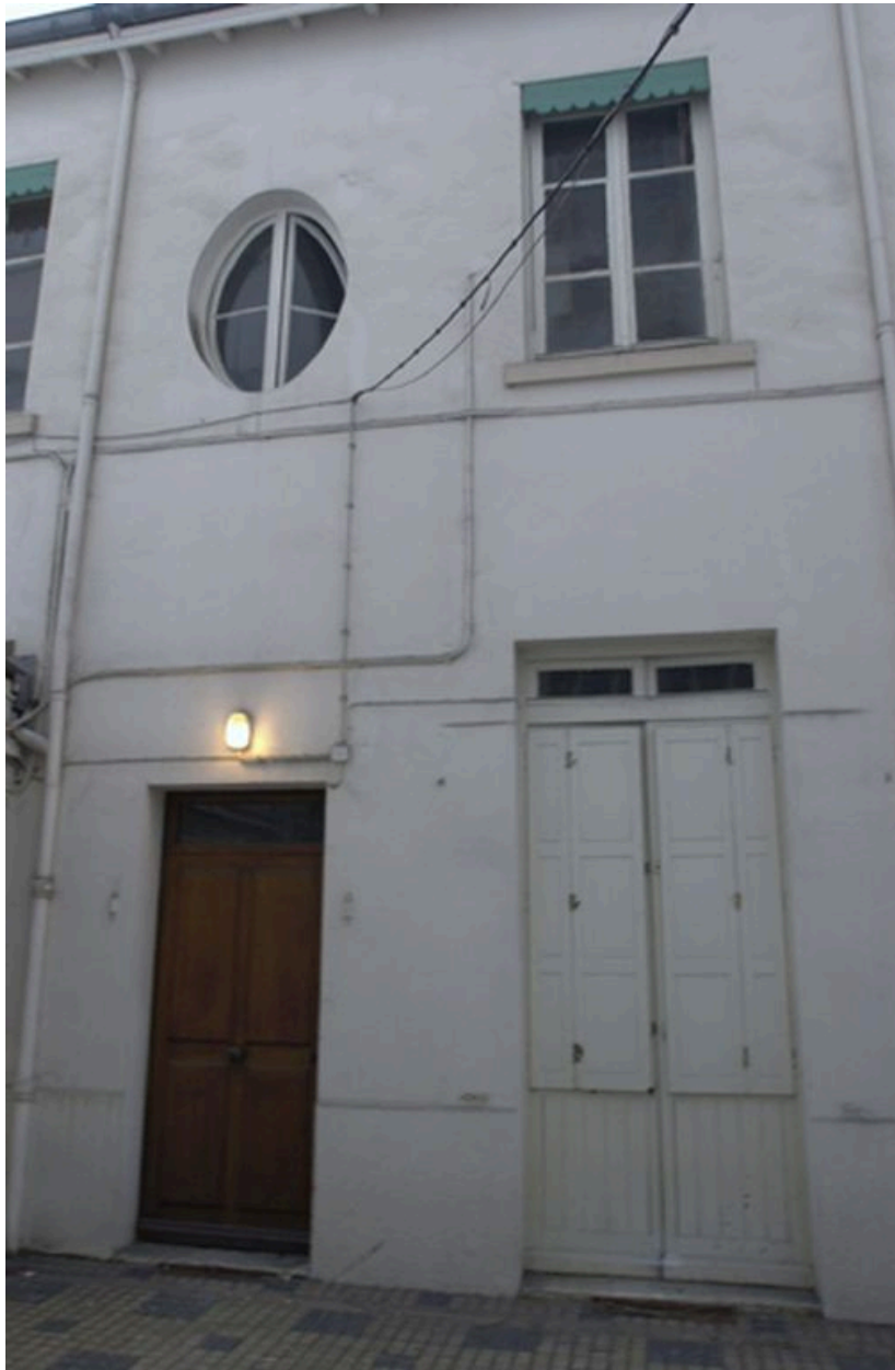
Façade du bâtiment sur cour
