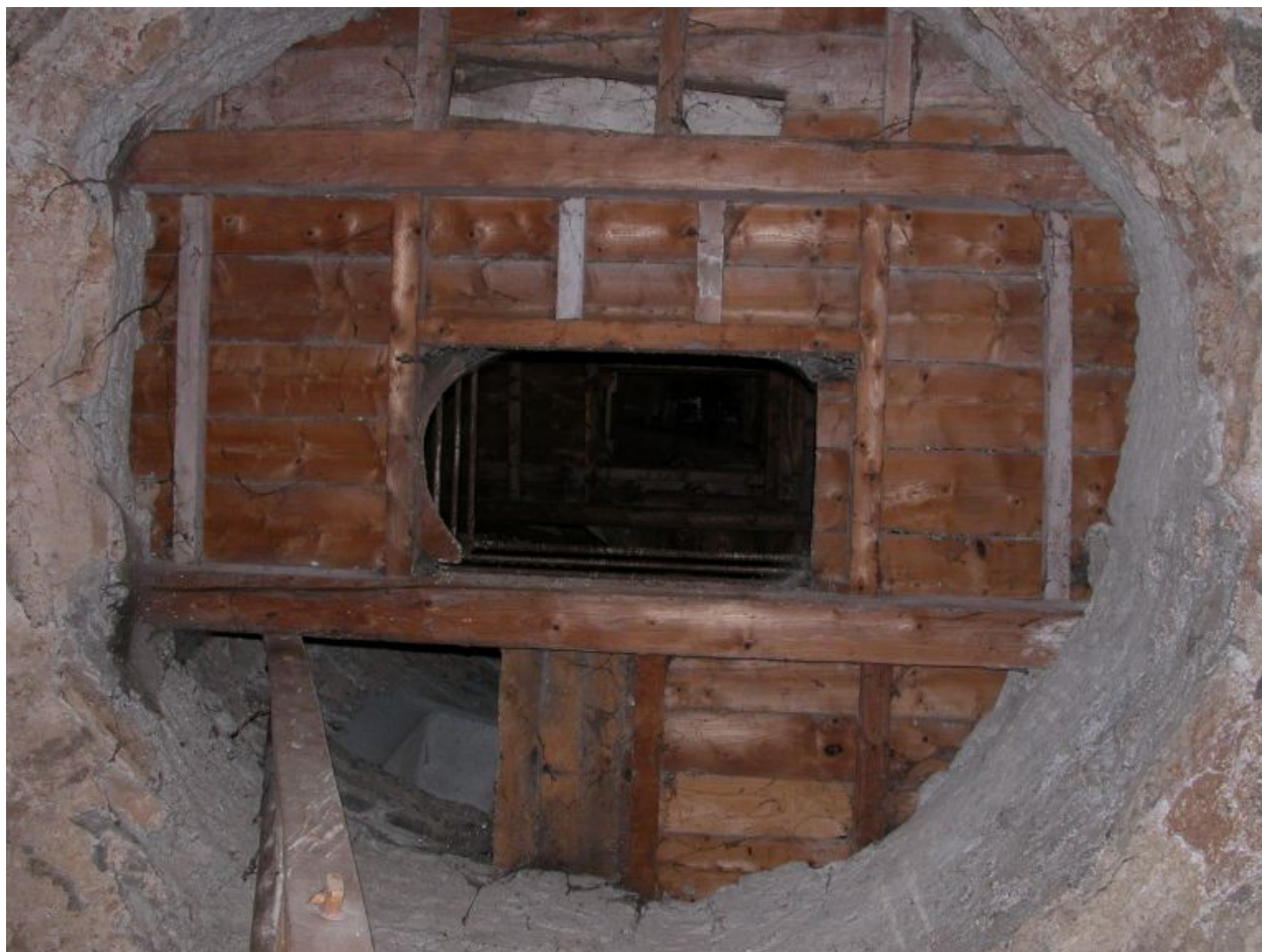
Plancher niveau 2. Enfilade des niveaux supérieurs.
