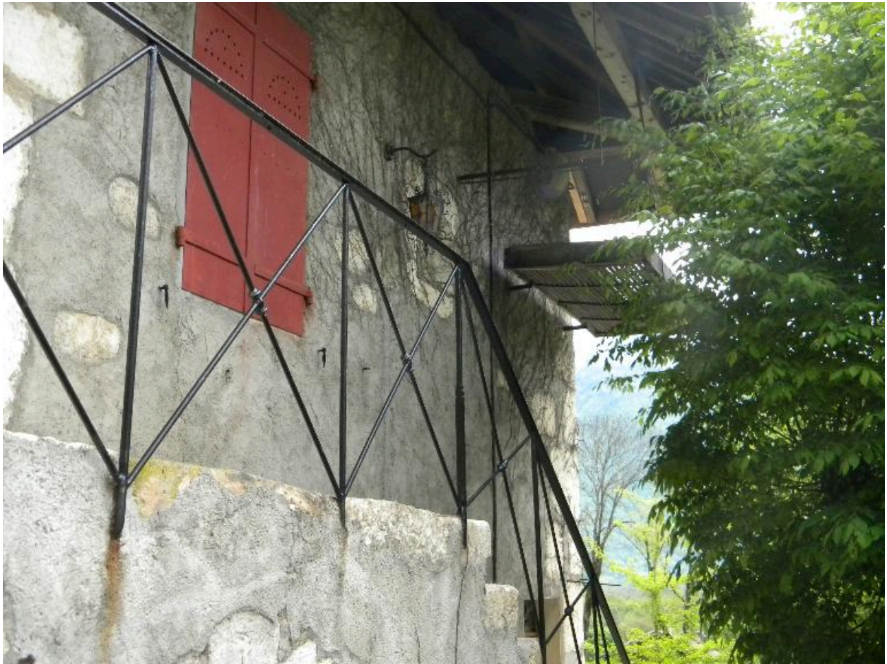
Vue d'un séchoir à noix en suspendu sous le débord de toit en façade principale.
