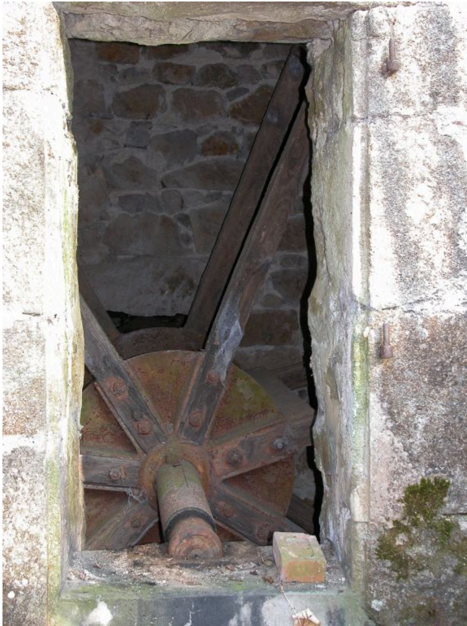
Façade ouest du moulin, accès roue à aubes.
